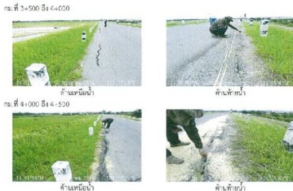
รูปที่ 2 รอยแตกตามยาวที่พบบนสันเขื่อนทั้งด้านเหนือน้ำและท้ายน้ำ [2]
