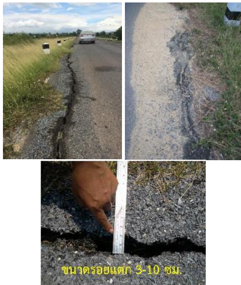
รูปที่ 3 ลักษณะรอยแตกตามยาวหลังจากการซ่อมผิวทาง [3]
