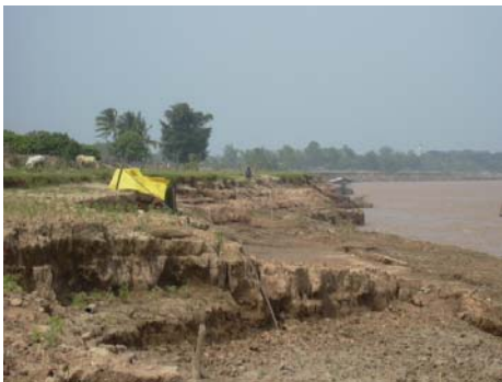
ภาพที่ 5 สภาพของตลิ่งที่เกิดการกัดเซาะ บ.ดงขวางท่า จ.นครพนม
