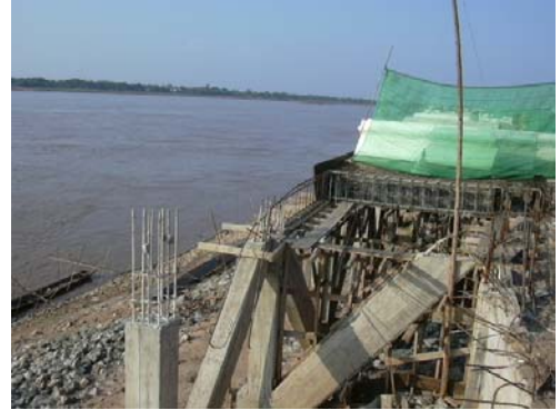
ภาพที่ 11 การก่อสร้างเขื่อนป้องกันตลิ่งแบบไต้ะวัดพระธาตุกลางน้ำ
