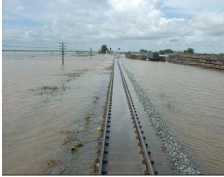
รูปที่ 1 สภาพน้ำท่วมคันทางรถไฟหลักเสาโทรเลขที่ 309/2
