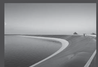
งานสะพานและบ่อเก็บน้ำ
