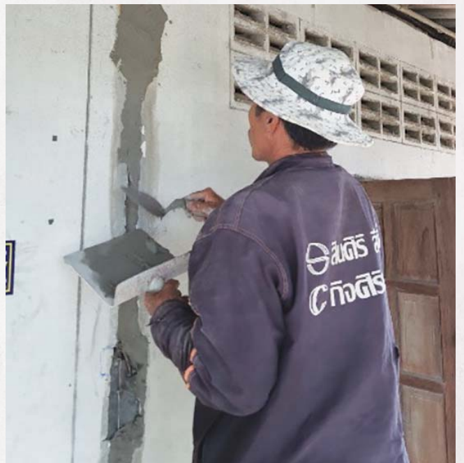
รูปที่ 12 การฉาบปิดรอยแตกระหว่างเสาและผนัง
