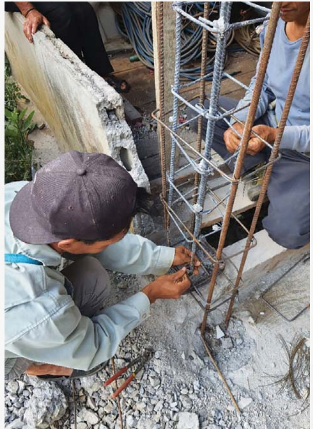
รูปที่ 19 การติดตั้งเหล็กเสริมเสา
