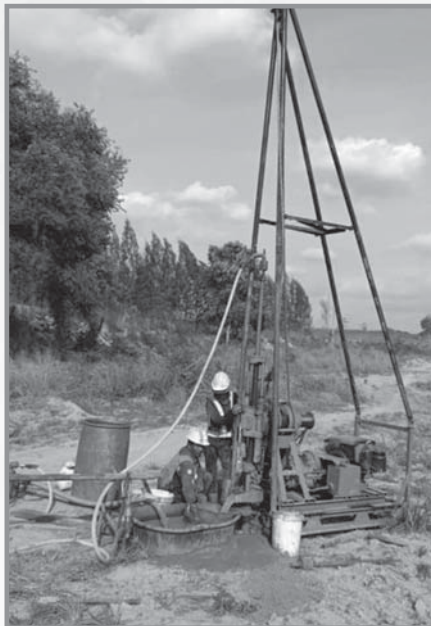
เจาะดินโดยวิธีเจาะปั่น (Rotary Drilling)
