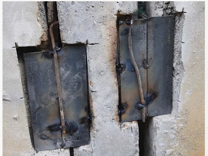
รูปที่ 11 การเสริมความแข็งแรงและเพิ่มการรับแรงดึงระหว่างเสาและผนัง โดยการใส่เหล็กฉาก
