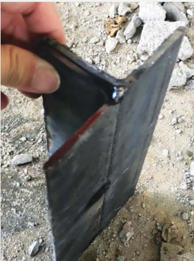
รูปที่ 10 ลักษณะของเหล็กฉากที่ใช้ (ขนาดความยาว 20 ซม.)
