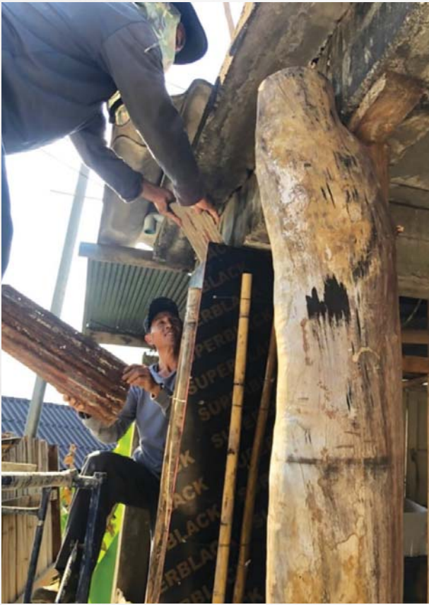
รูปที่ 21 การเทคอนกรีตเสาใหม่
