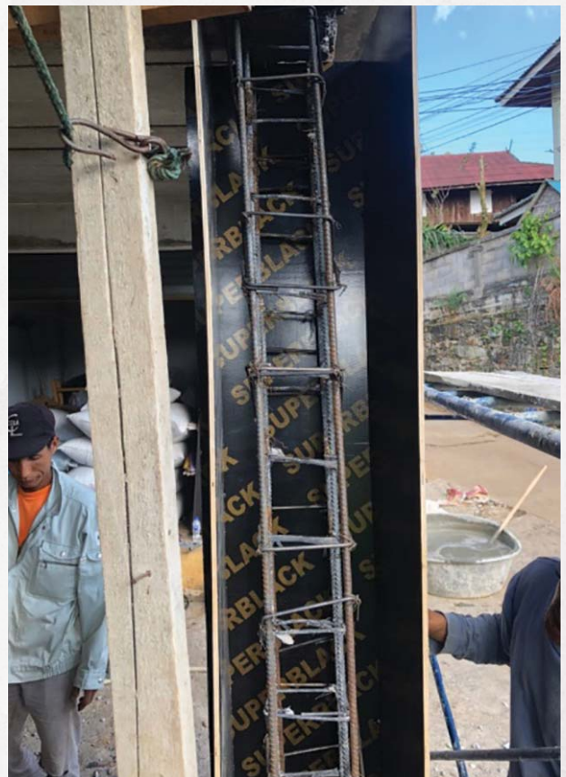
รูปที่ 20 การติดตั้งไม้แบบเสาใหม่
