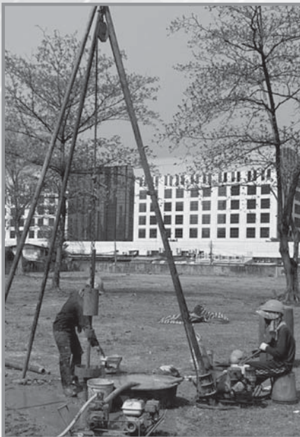
เจาะดินโดยวิธีฉีดล้าง (Wash Boring)
