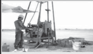
งานเจาะสำรวจดิน
