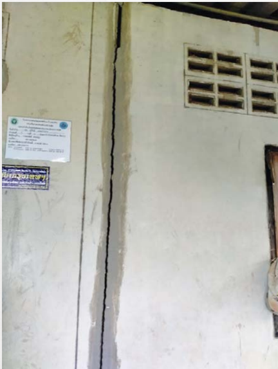
รูปที่ 6 รอยแตกระหว่างเสากับผนัง
