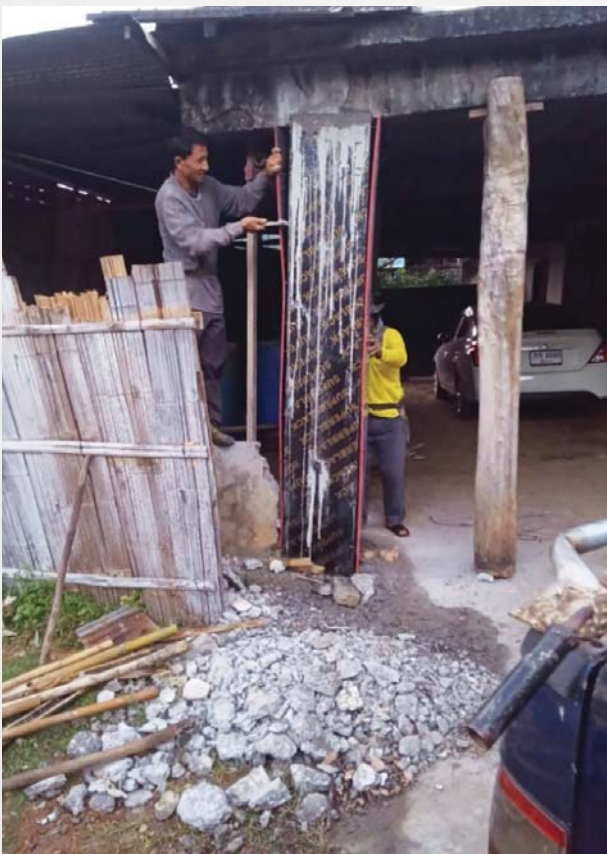
รูปที่ 22 การถอดไม้แบบ
