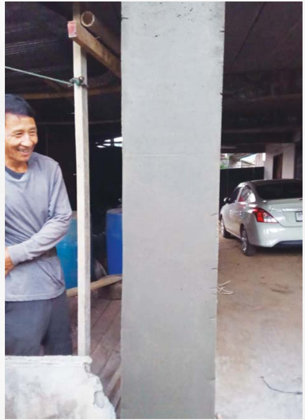
รูปที่ 23 ลักษณะเสาคอนกรีตเสริมเหล็กภายหลังการซ่อมแซม
