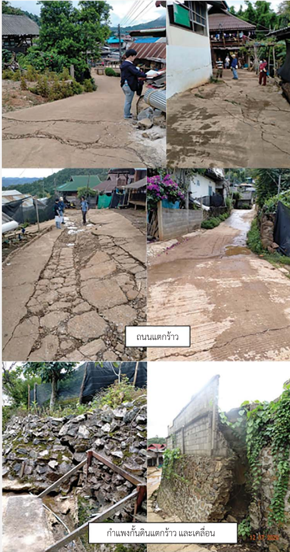
รูปที่ 5 ตัวอย่างลักษณะรอยแตกร้าว บริเวณพื้นที่หมู่บ้านดอยช้าง
