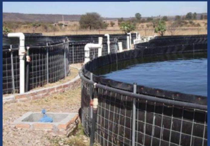
บ่อเก็บน้ำโดยเฉพาะในหน้าแล้ง
