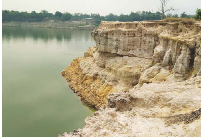
รูปที่ 3 ลักษณะการพังทลายโดยเกิดจากการกัดเซาะด้านล่าง (Under Cut Failure)
