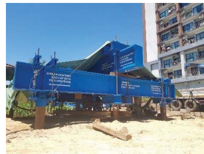
รูปที่ 3 ประกอบคานเหล็กเพื่อใช้ทดสอบ
