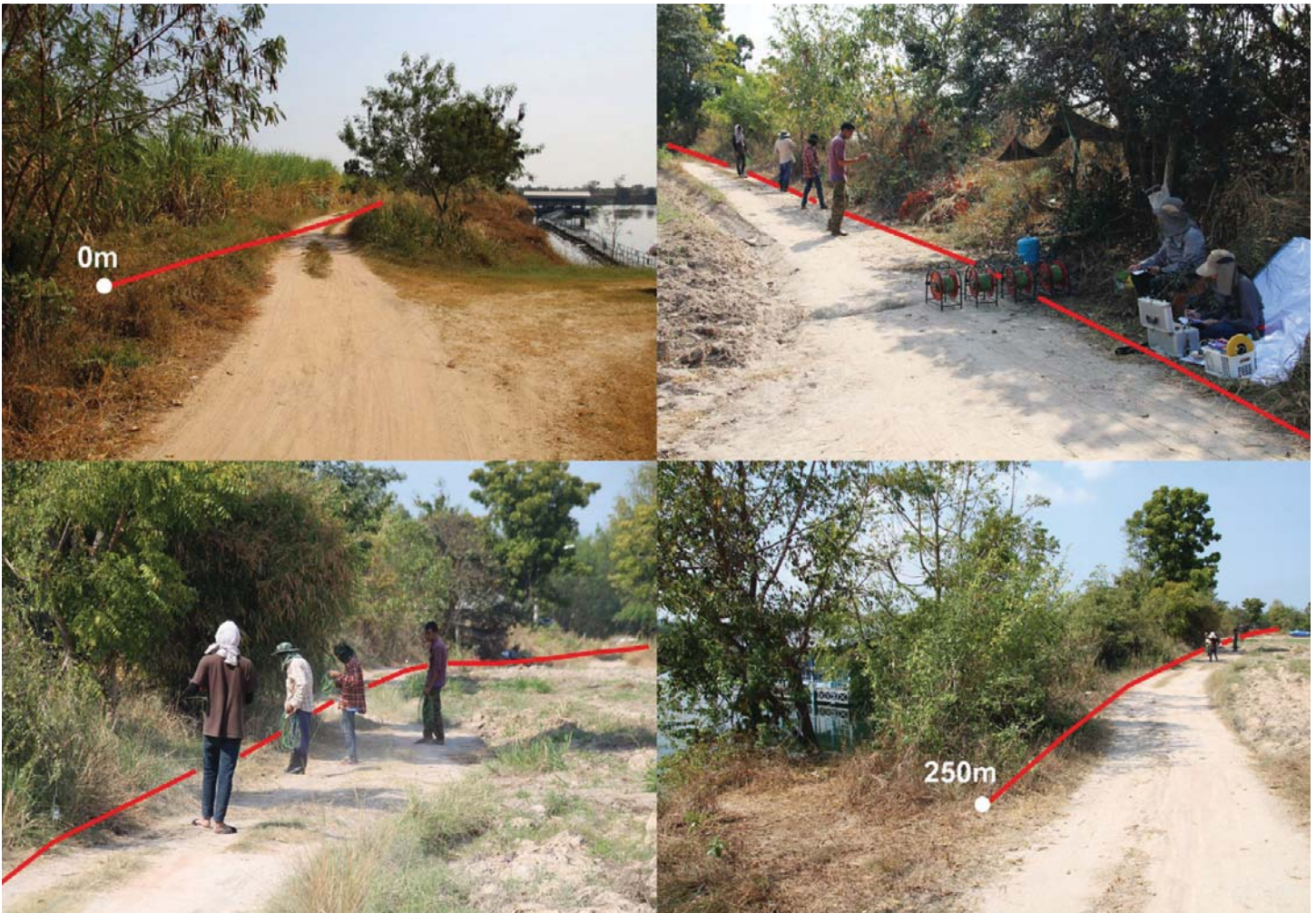
รูปที่ 9 ตัวอย่างการสำรวจแนวสำรวจค่าความต้านทานไฟฟ้า
