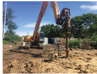
รูปที่ 2 ติดตั้งเสาเข็มทดสอบ
