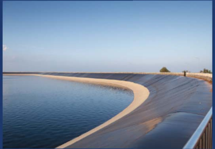
งานชลประทานและบ่อเก็บน้ำ
