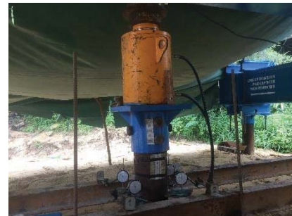
รูปที่ 4 ตรวจสอบการทรุดตัวจาก Dial gauges
