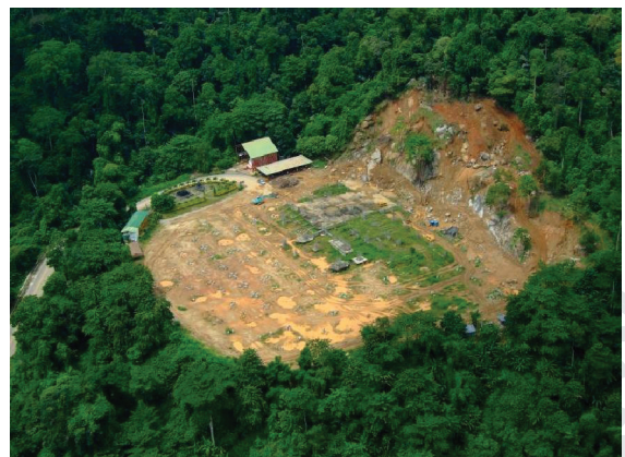
รูปที่ 2 ลักษณะพื้นที่ก่อสร้างโครงการ
