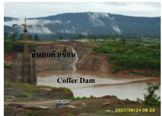
ภาพที่ 6 ปริมาณน้ำหลากทำให้น้ำไหลล้นข้ามCoffer Dam
