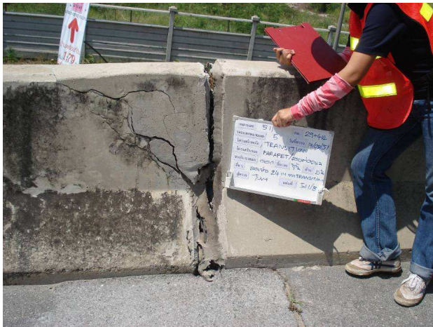
ภาพที่ 7 ลักษณะความเสียหายของผนังกันตก
