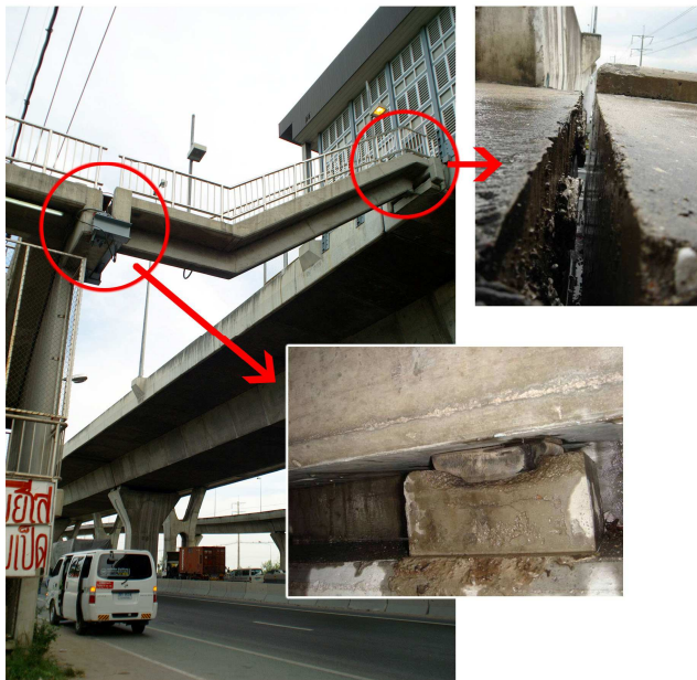
ภาพที่ 11 ลักษณะการเคลื่อนตัวของบริเวณฐานรองรับบันได
