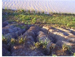
(ก) ลักษณะการกัดเซาะเป็นร่องน้ำแบบลึกบริเวณขอบอ่าง
