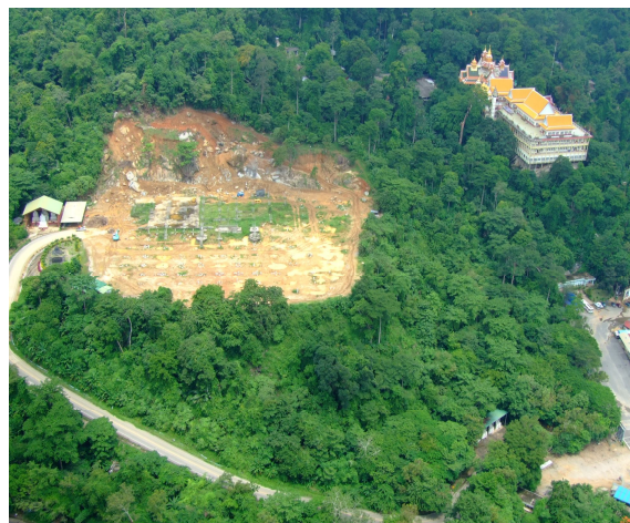
ภาพที่ 1 ลักษณะพื้นที่ก่อสร้าง
