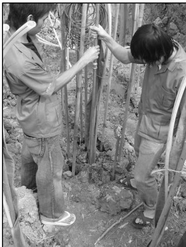
รูปที่ 7 แสดงการติดตั้ง KU - Piezometer โดยการกด
