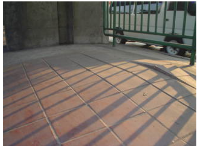
รูปที่ 2 ขยายรอยปริงของทางเท้าได้ทางยกระดับที่แสดงในรูปที่ 1
