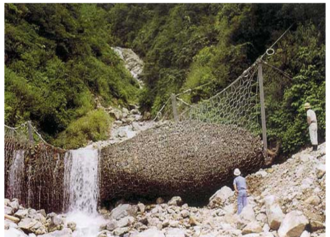
รูปที่ 3 การติดตั้งแนวรั้วตาข่ายเพื่อป้องกันมวลวัสดุที่เกิดจากการพิบัติของลาดดิน [4]
